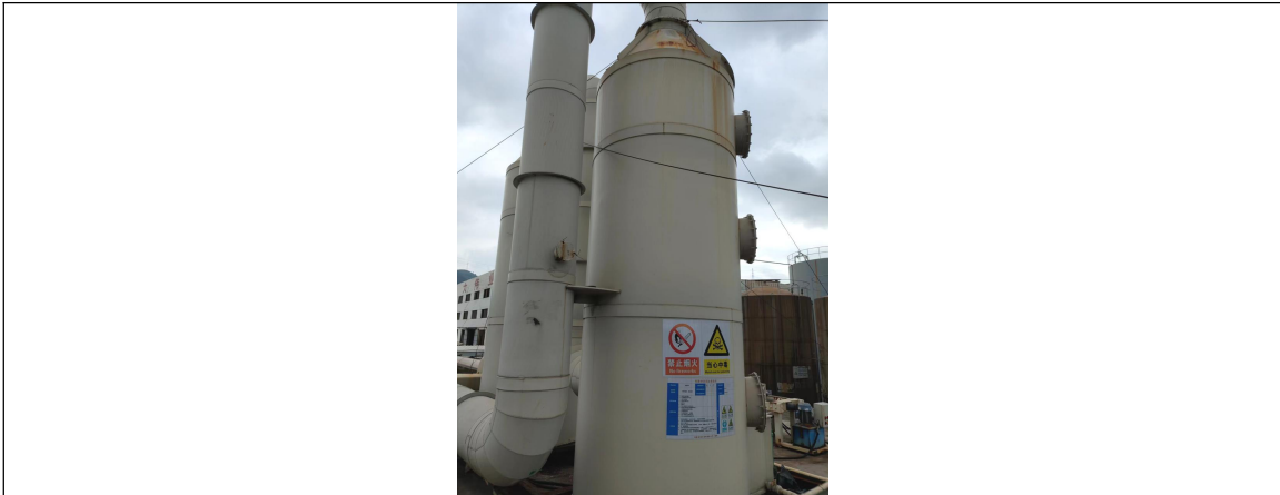
图 2-11 DMF 精馏回收塔及污水站臭气处理设施现场照片
