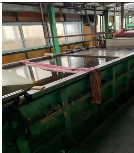
凝固槽密闭装置
